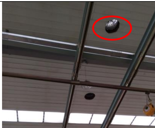
焊接烟尘的屋顶收集系统
